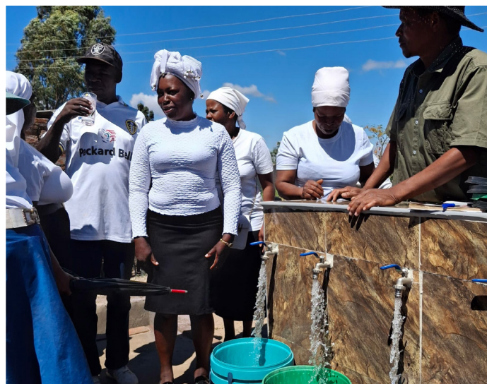
Solcelledrevet borehul installeret og fuldt operationelt – forsyner ca. 3.000 mennesker.
